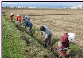
水路の泥上げ
