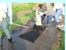
農道の部分補修
