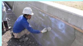
老朽化した水路壁のコーティング
