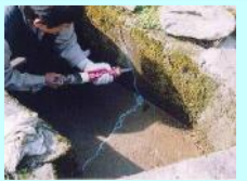
水路のひび割れ補修
