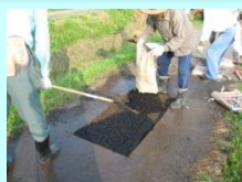
農道の部分補修
