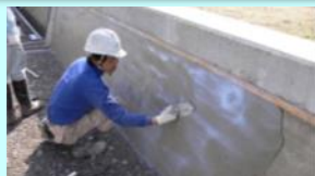
老朽化した水路壁のコーティング
