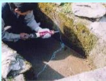
水路のひび割れ補修
