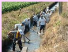
水路の泥上げ
