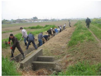
( 水路清掃作業 )
