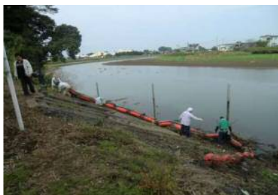
( ゴミよけネット設置 )
