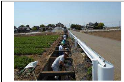
( 水路の泥上げ )
