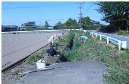
( 水路の泥上げ )
