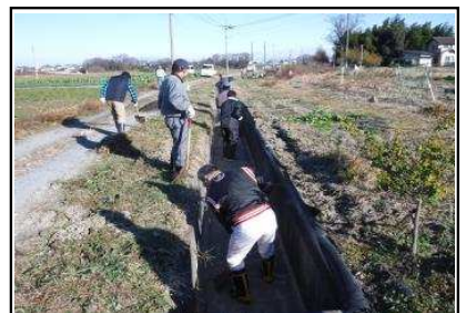
( 水路の泥上げ )
