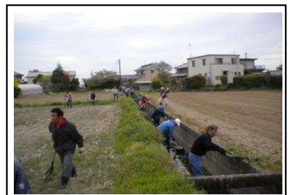
( 水路の泥上げ )
