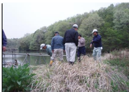
(ため池の点検)
