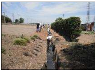
( 水路の泥上げ )
