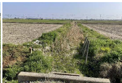
長寿命化による排水路工事の希望箇所の様子
