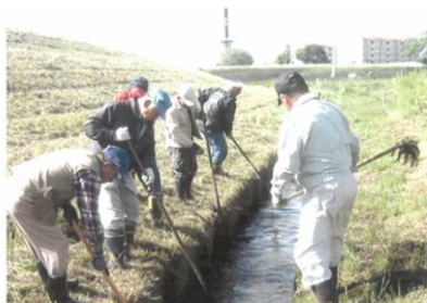
( 水路の泥上げ作業 )
