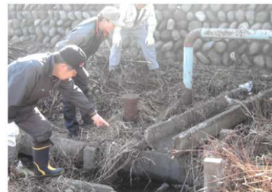
( 水路の点検活動 )
