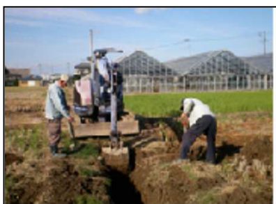
( 水路の泥上げ )
