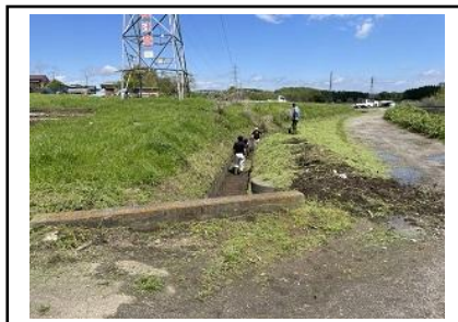
(水路の砂利撤去)
