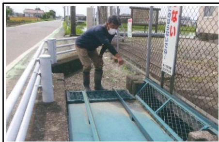
(施設の点検作業)
