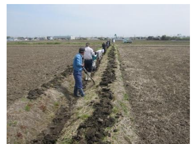
( 水路の泥上げ )
