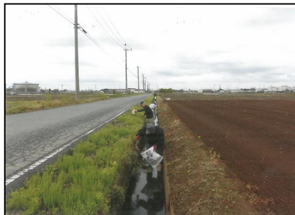
( 水路の泥上げ )
