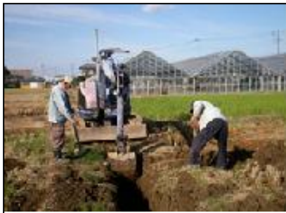
( 水路の泥上げ )
