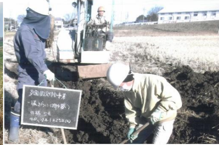
( 水路の泥上げ )
