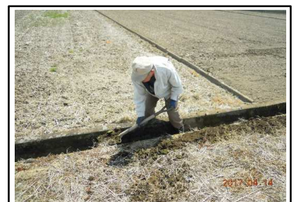
( 水路の泥上げ )
