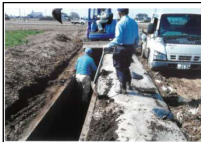
( 水路の泥揚げ )
