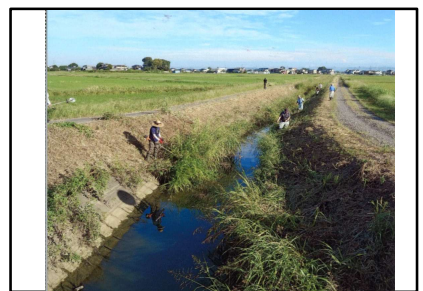
(水路草刈り・泥上げ)
