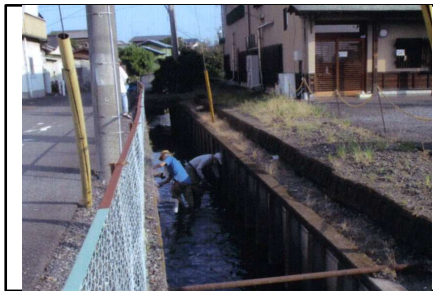
(水路の草刈り・泥上げ)
