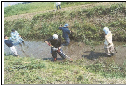
(水路の草刈り・泥上げ)
