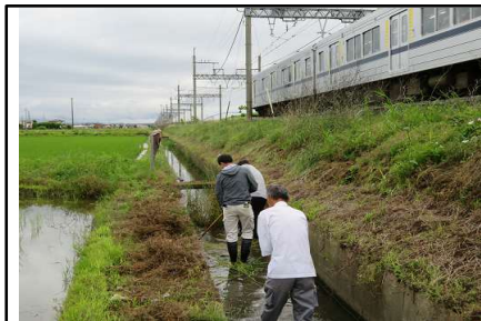
(水路草刈り・泥上げ)
