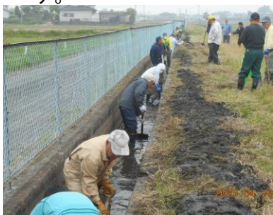
( 水路の泥上げ作業 )
