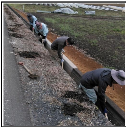
（水路泥さらい状況）
