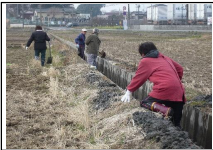
（ 水路泥さらい作業 ）
