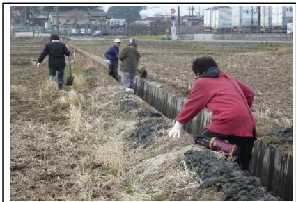
（ 水路泥さらい作業 ）
