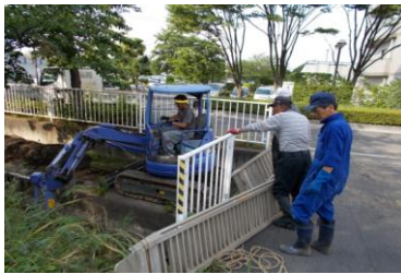
(水路の泥上げ)
