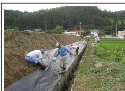
( 防草シート張り )
