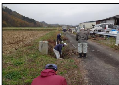
( 排水路の泥上げ )
