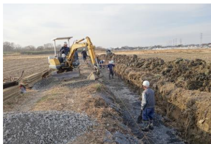
( 水路更新作業 )
