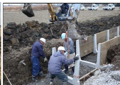
( 水路更新作業 )
