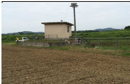
(ポンプ小屋周辺の草刈り)
