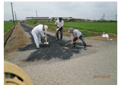
(農道砂利補修)
