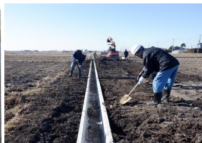
(コンクリート水路への更新)
