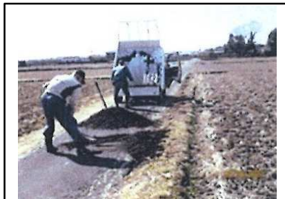
( 農道の軽微な補修 )
