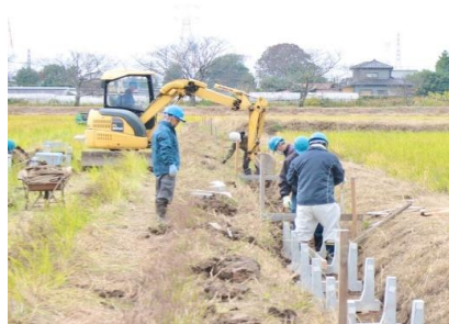
( 水路敷設工事 )
