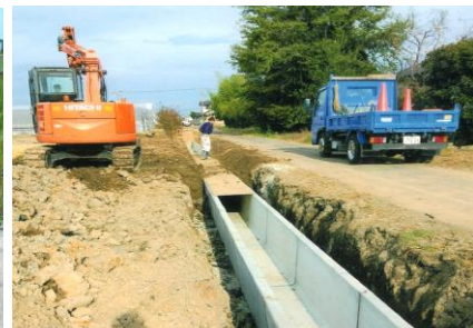
( 水路敷設工事 )
