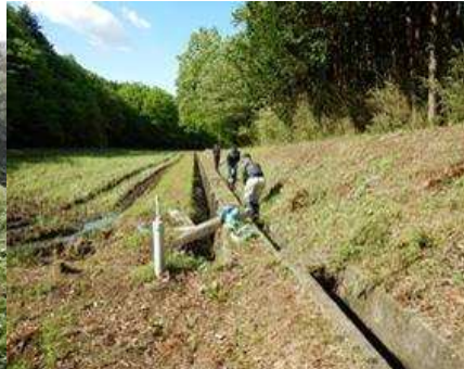
( 水路の泥上げ )
