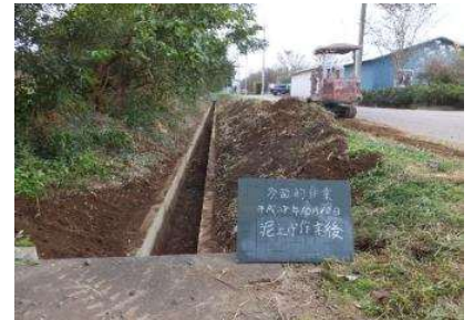
( 水路の泥上げ )
