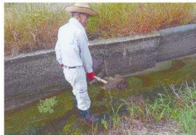
( 水路の泥上げ )
