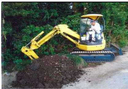
( 水路の泥上げ )
