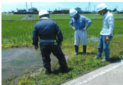
( 台風後の点検 )
