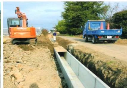
( 水路敷設工事 )
