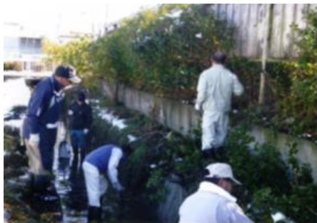
( 水路の浚渫作業 )
