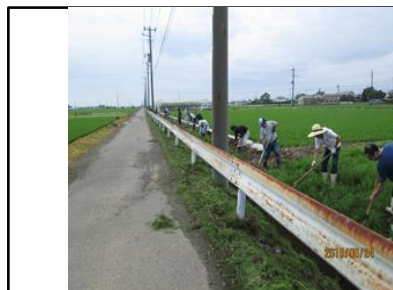
( 水路脇の保安全管理 )
