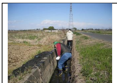
( 水路の泥上げ )
