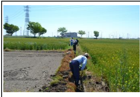
（ 水路の泥上げ ）
