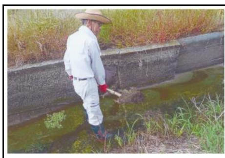
（水路の泥上げ）
