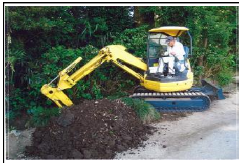
（水路の泥上げ）
